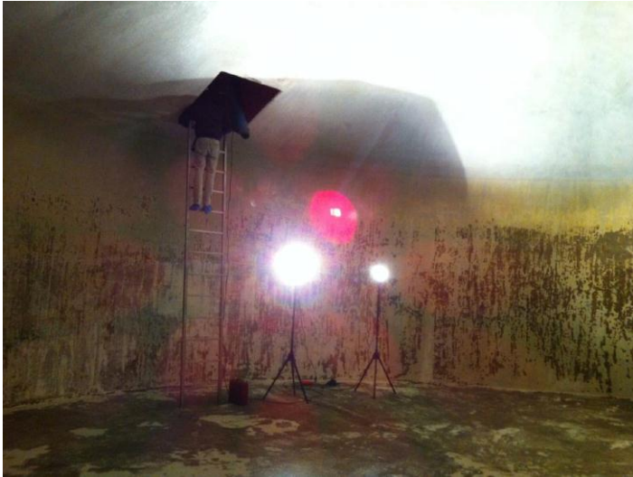
Intérieur de la cuve
