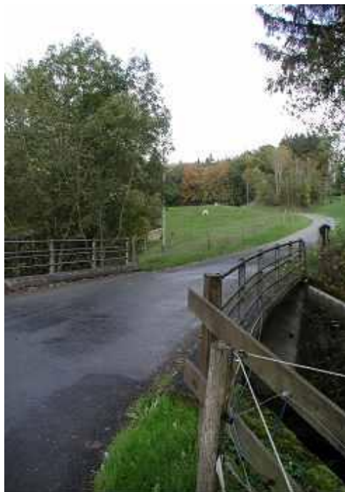
Franchissement du Veyron à Mauraz
