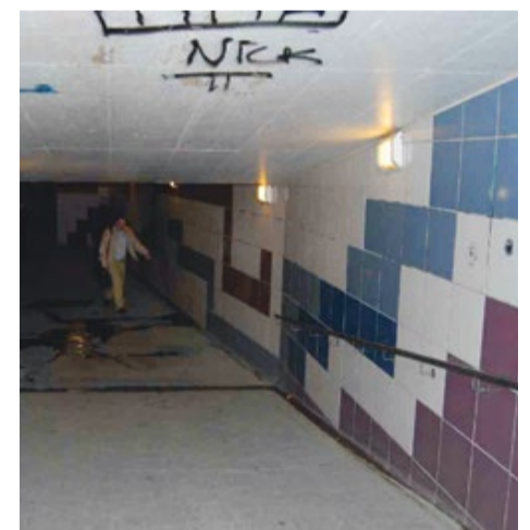
7 Travaux: passage inférieur des Charpentiers
