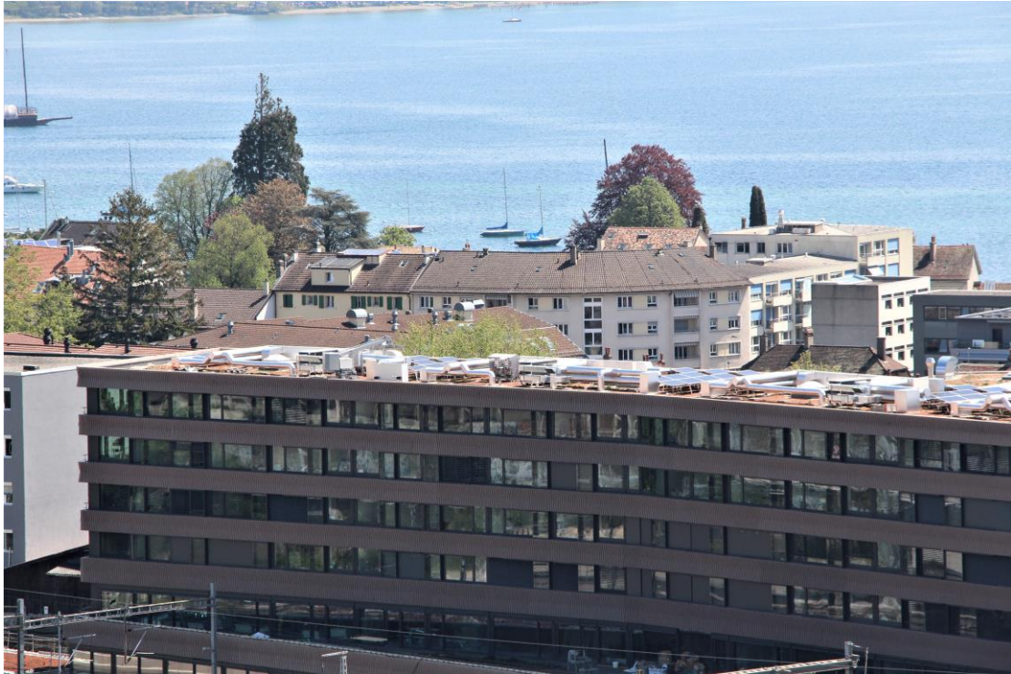
Vue « aérienne » des toits du quartier Gare-Sud (aire de construction Sablon Gare-Rail).
