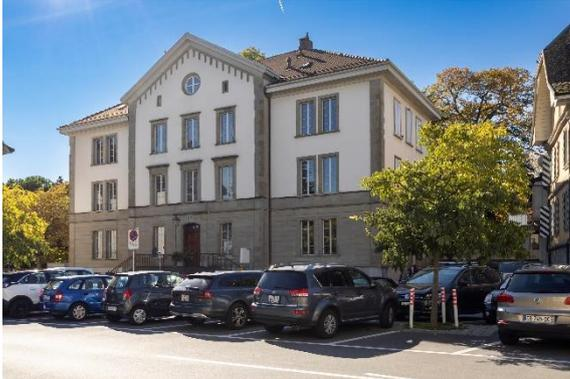
Le bâtiment du Bluard a été construit en 1848, sur l'emplacement de l'ancien hôpital. Des travaux de réfection ont été réalisés en 1951-1952. Divers autres travaux ont été effectués entre 1971 et 1983 allant de la réfection des classes, à la modernisation de la chaufferie ou au remplacement des vitrages. Depuis cette date, des travaux d'entretien courants ont été réalisés, mais aucune transformation, ni rénovation d'ampleur ne sont à signaler. Ce bâtiment a
