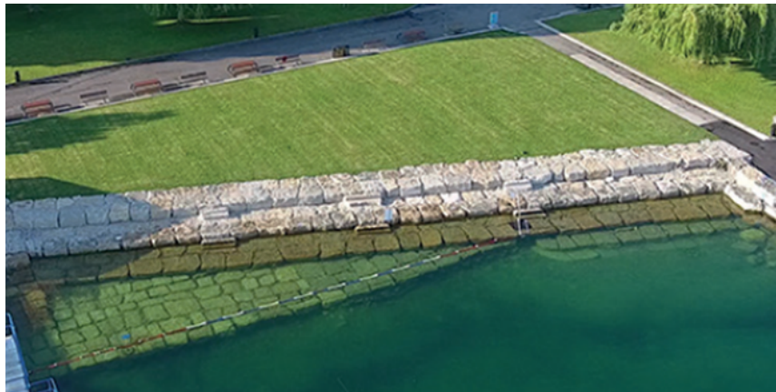
Exemple d'enrochements : Port Noir, Cologny
